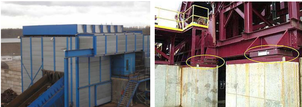
Şekil 4 Öğütücü için Bölücü Susturucular (sol) ve İzolasyon Elemanları (sağ) [ 5]
