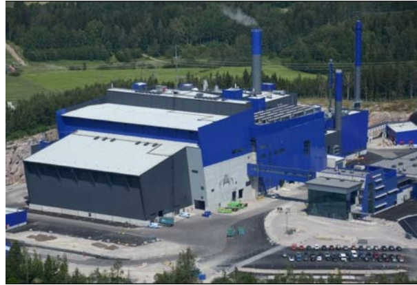
Şekil 14 Doğu Vantaa (Finlandiya) Atıktan-Enerji Tesisi
