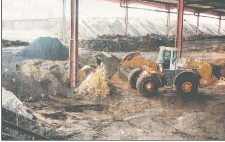
Şekil 6 DDT'de Taşınabilir Çatı Uygulaması
