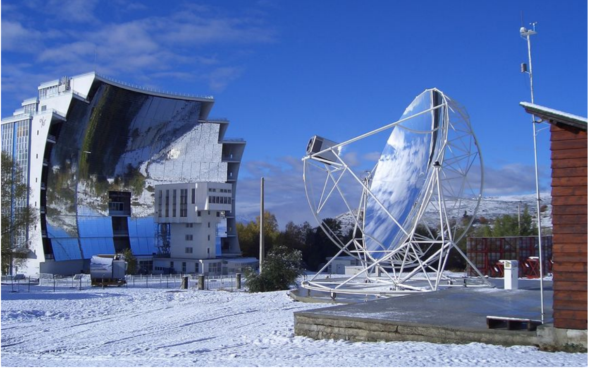
Şekil 4: Odeillo, Fransa'daki 10 kW Çanak/Stirling EuroDish [kaynak: http://www.sbp.de/en/projects/#.cat-11 ]
