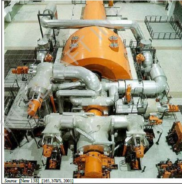
Şekil 1: Kömür yakıtlı santralin buhar türbini
