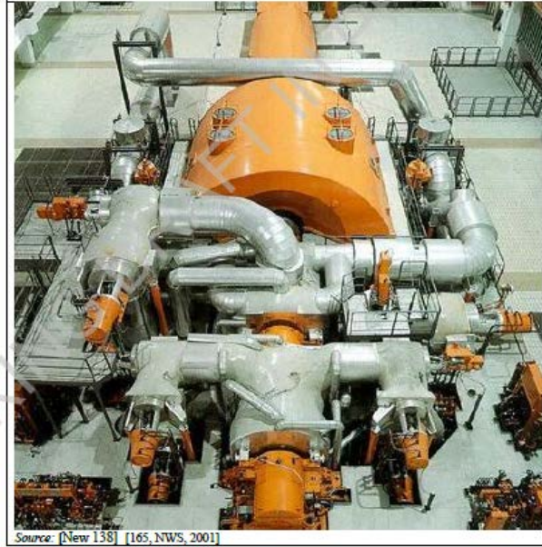
Şekil 1: Kömür yakıtlı santralin buhar türbini
